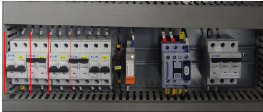
Figura 39. TDR-001 Tablero de Distribución Tensión Regulada 24 VDC
