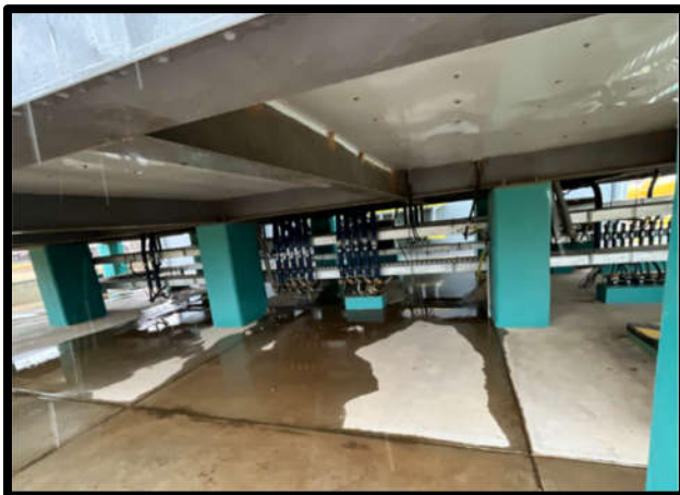
Figura 14. Bandejas de instrumentación
