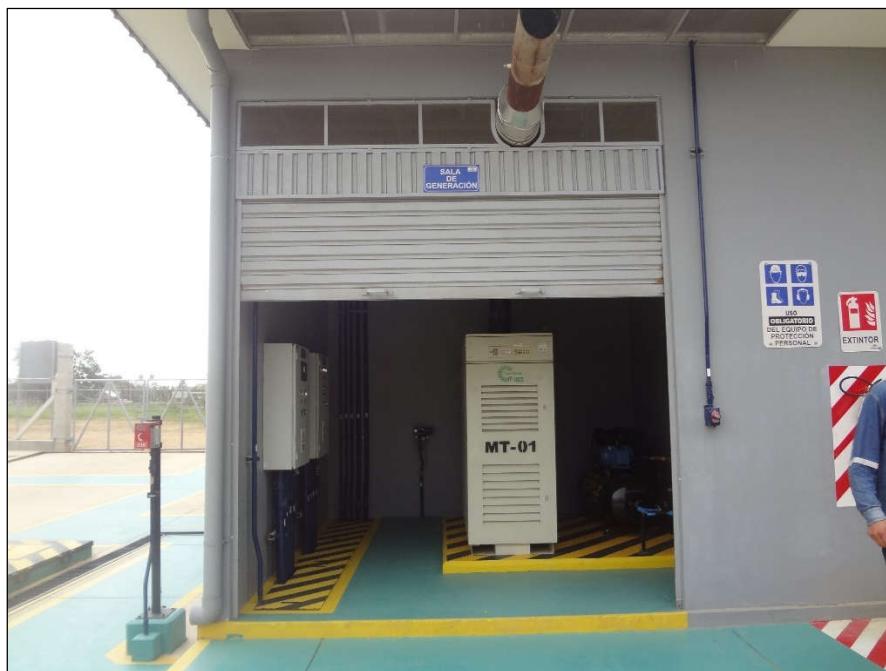
Figura 44. ST-001 Tablero de Transferencia
