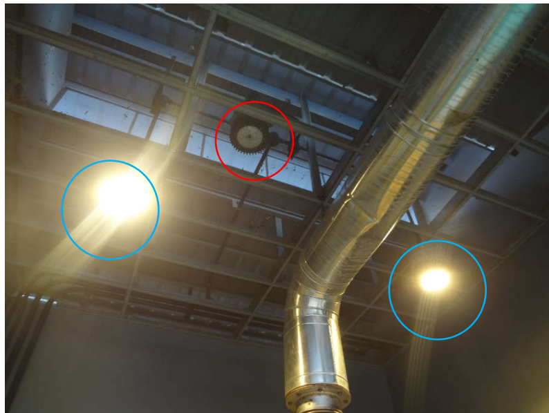
Figura 53. Iluminación General (circulo azul) y de Emergencia (circulo rojo)
