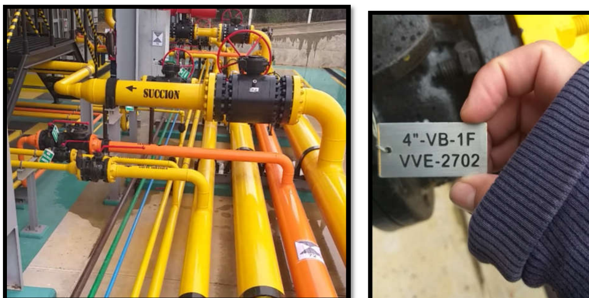
Figura 5. Servicios del Compresor 2/ válvulas principales
