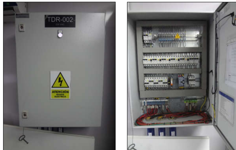
Figura 37. TDR-002 Tablero de Distribución Tensión Regulada 220 VDC
