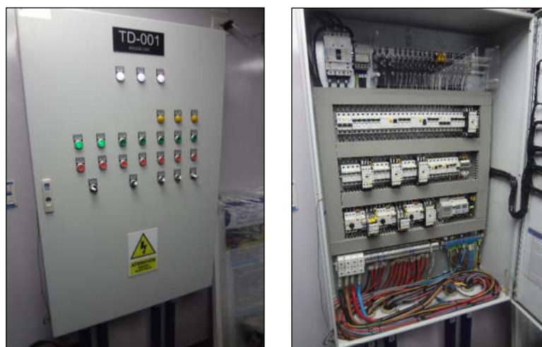
Figura 35. TD-001 Tablero de Distribución General
