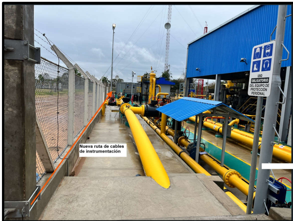
Figura 13. Ruta de nueva canalización
