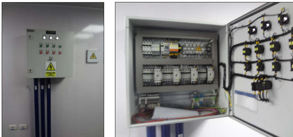
Figura 34. TD-004 Tablero de Iluminación Perimetral
