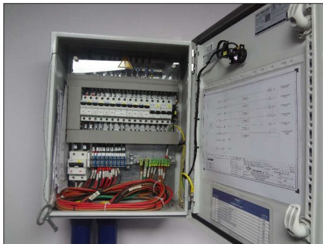
Figura 39. TDR-001 Tablero de Distribución Tensión Regulada 24 VDC
