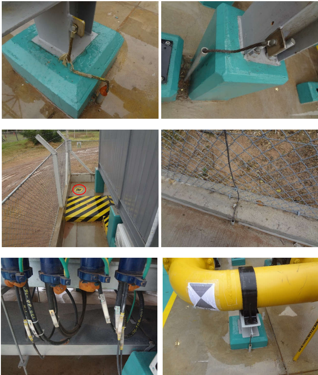
Figura 50. Puesta a tierra Existente
