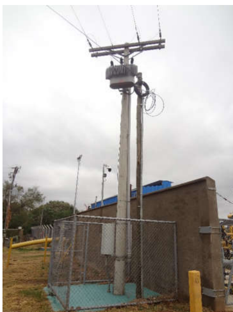
Figura 55. Transformador de 75 KVA y puesto de transferencia.
