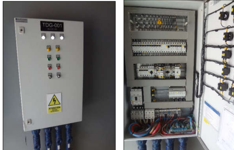
Figura 46. TDG-001 Tablero de Distribución General
