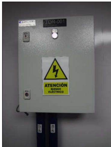
Figura 39. TDR-001 Tablero de Distribución Tensión Regulada 24 VDC
