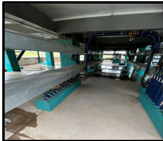
Figura 14. Bandejas de instrumentación
